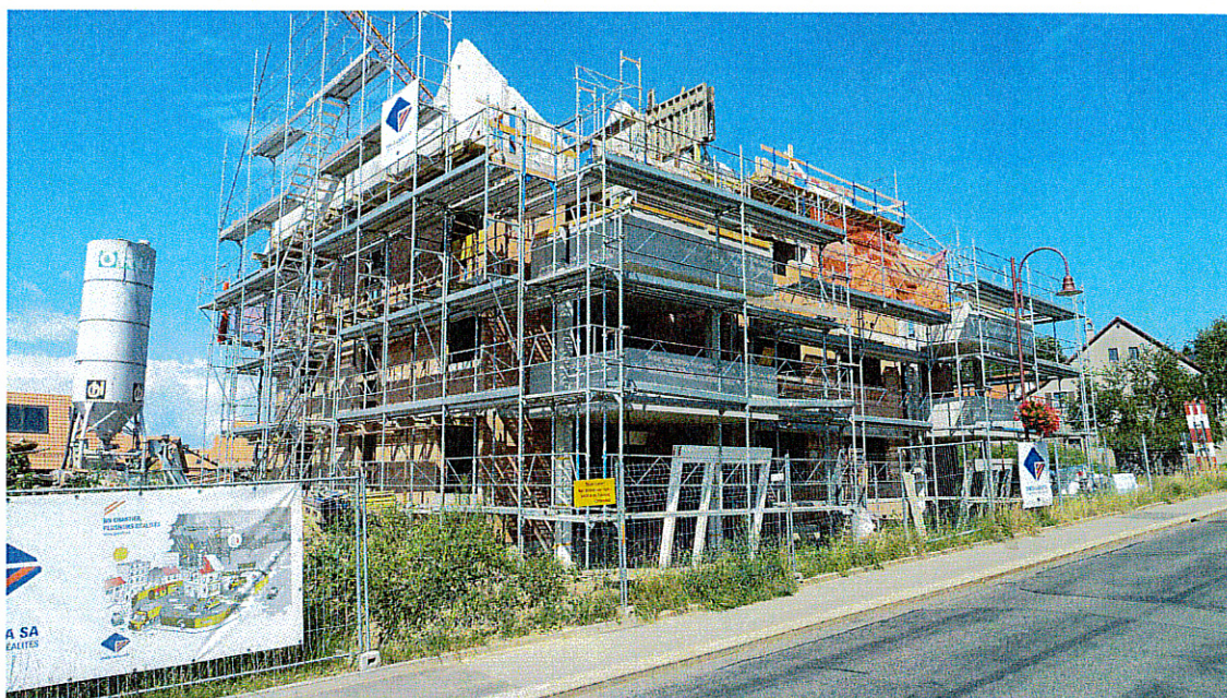
Derniers bâtiments en construction dans le plan de quartier Raffort (ch. de la Plaine)
