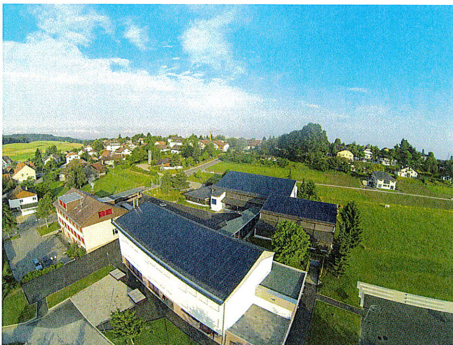
Site scolaire dès la rentrée 2013 avec les panneaux solaires en toiture
