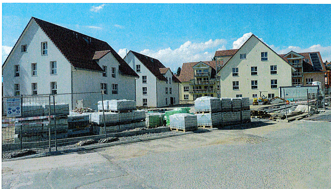
Construction de plusieurs bâtiments au ch. du Closel
